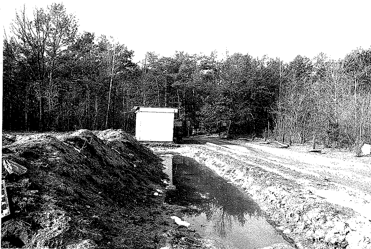
Fot. nr 3. Wjazd na składowisko oraz urządzenia infrastruktury składowiska – między innymi widoczny brodzik dezynfekcyjny dla samochodów. Na pierwszym planie rów opaskowy wokół kwatery wysypiska
