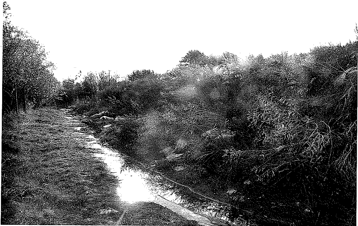
Fot. nr 5. Widok na północne i północno - wschodnie obwałowanie zewnętrzne kwatery składowiska
